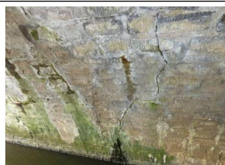
**FIGURE 5 - LONGITUDINAL CRACKING IN ARCH**
