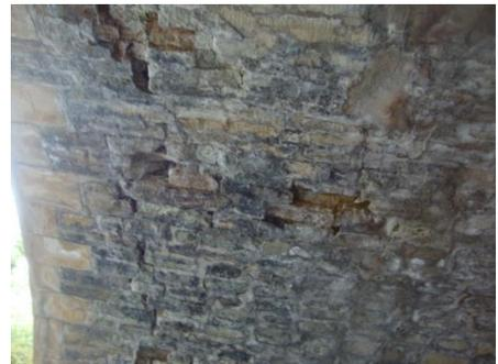
**FIGURE 6 - LONGITUDINAL CRACKING AND SPALLING**
