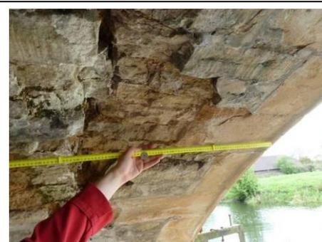
**FIGURE 4 - WEATHERED STONE AND CRACK ALONG THE EDGE OF THE VOUSSIORS**
