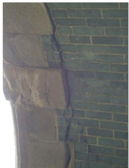
**FIGURE 7 - LONGITUDINAL CRACKING BETWEEN VOUSSOIRS AND ARCH**
