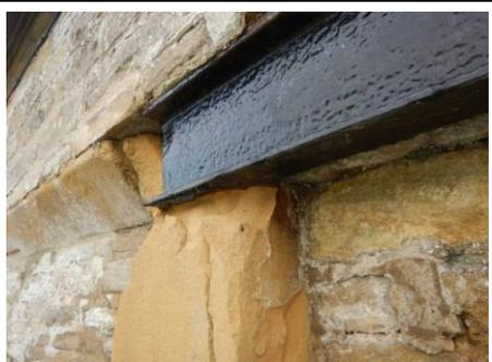
**FIGURE 11 – DAMAGE EAST END CORBEL**
